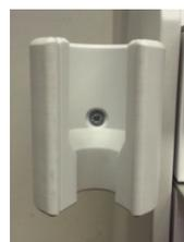
Im Anschluss montieren Sie bitte den Leuchtenhalter ebenfalls an der linken Schrankseite mittels der mitgelieferten Schrauben an der vorgesehenen Position (s. Pkt.1). Nun ist es Ihnen möglich die vormontierte Absaugleuchte in den Leuchtenhalter einzustecken. Beachten Sie an dieser Stelle die Hinweise des Beilegers im Leuchtenhalter.
